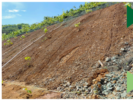
Kondisi Lahan SESAAT SETELAH APLIKASI GREEN STIQSLOPE Hydroseeding dengan Benih LCC
