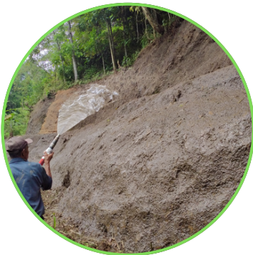
Material hydroseeding ( STIQSLOPE® ) dengan Perekat STIQFIER® disemprot di atas lahan dengan kemiringan >65°
